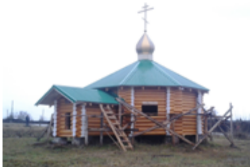
Село Новорождественское. Строительные леса вокруг нового храма. Фото автора.
